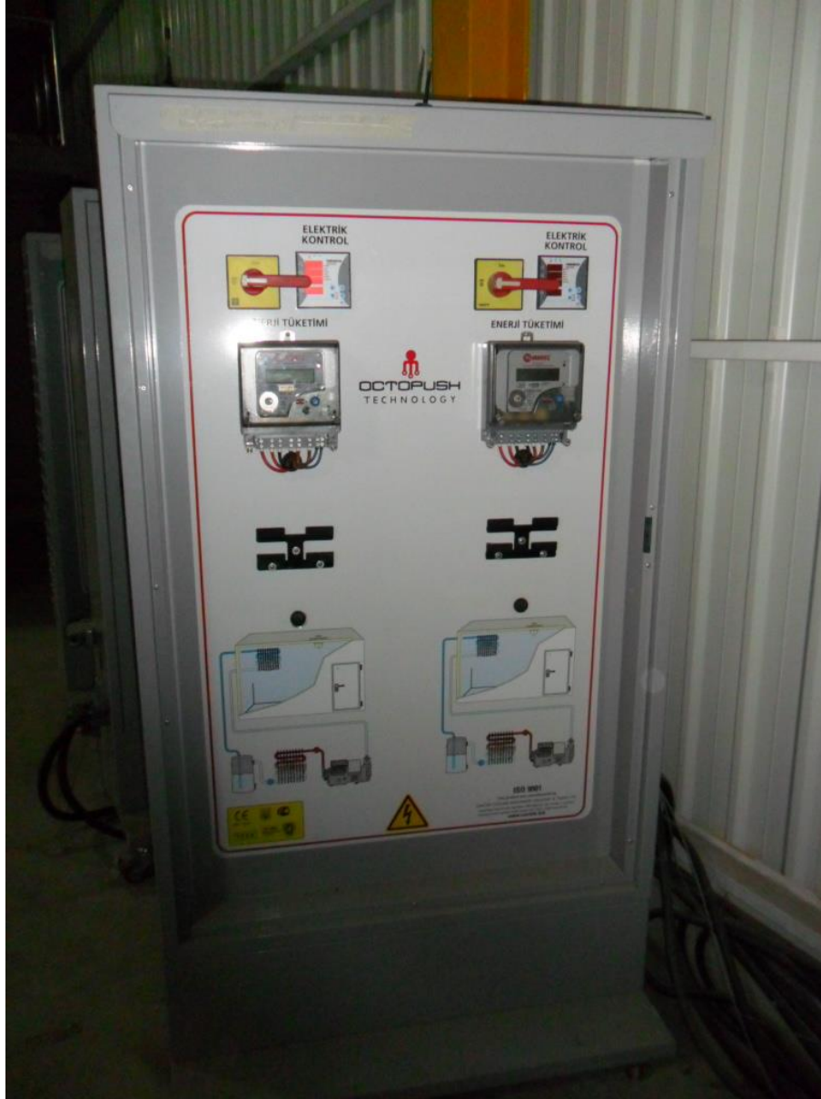
FOTOĞRAF-8) TEST ODALARININ ELEKTRİK TÜKETİMİNİN İZLENDİĞİ SAYAÇLAR
